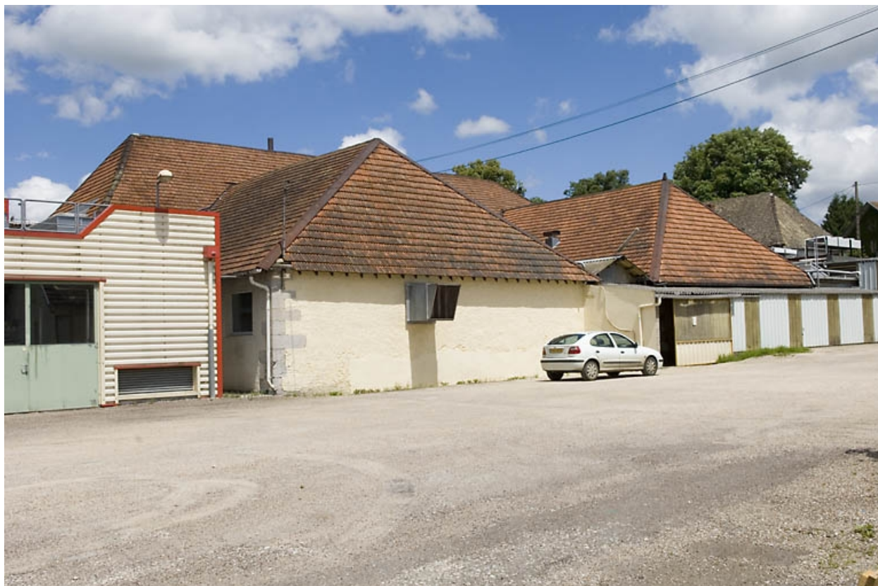
Halle de fonderie depuis le sud.
