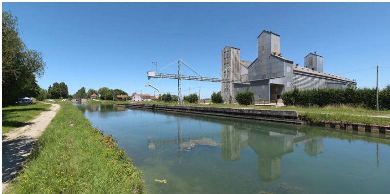
Silos à Longecourt-en-Plaine.
