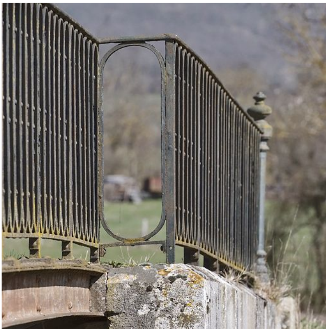
Le pont routier, détail des garde-corps.
