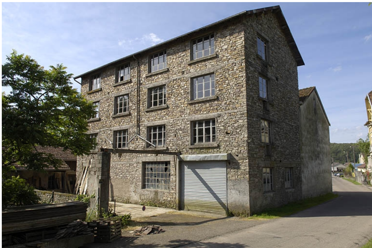
Extension orientale de l'atelier de fabrication.
