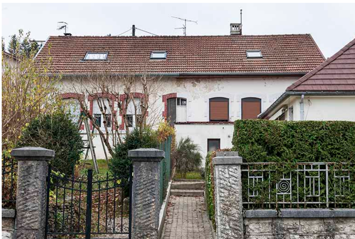
Atelier de fabrication : façade antérieure.
