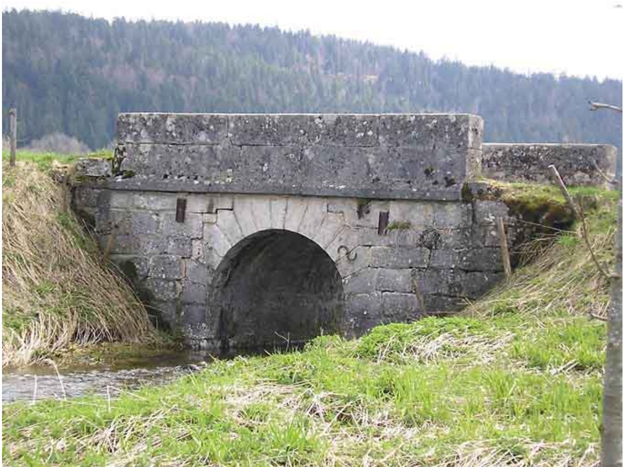
Pont situé au lieu-dit Le Maréchet.
