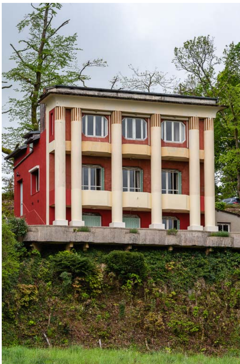
Façade nord, vue de trois-quarts.
