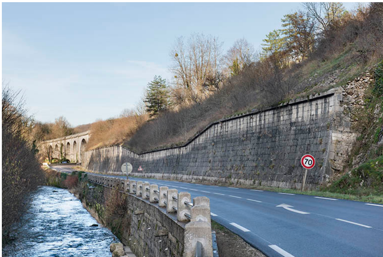
Viaduc et mur de soutènement, depuis l'est.
