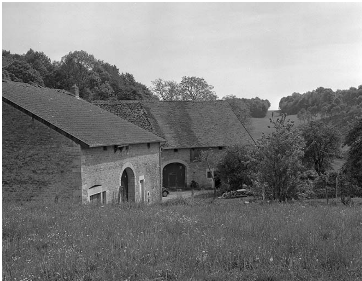
Ferme située au lieudit Chez les Basset : façade antérieure.
