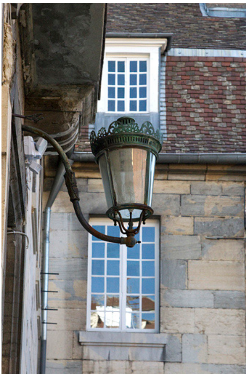
Façade antérieure : détail du bec de gaz.
