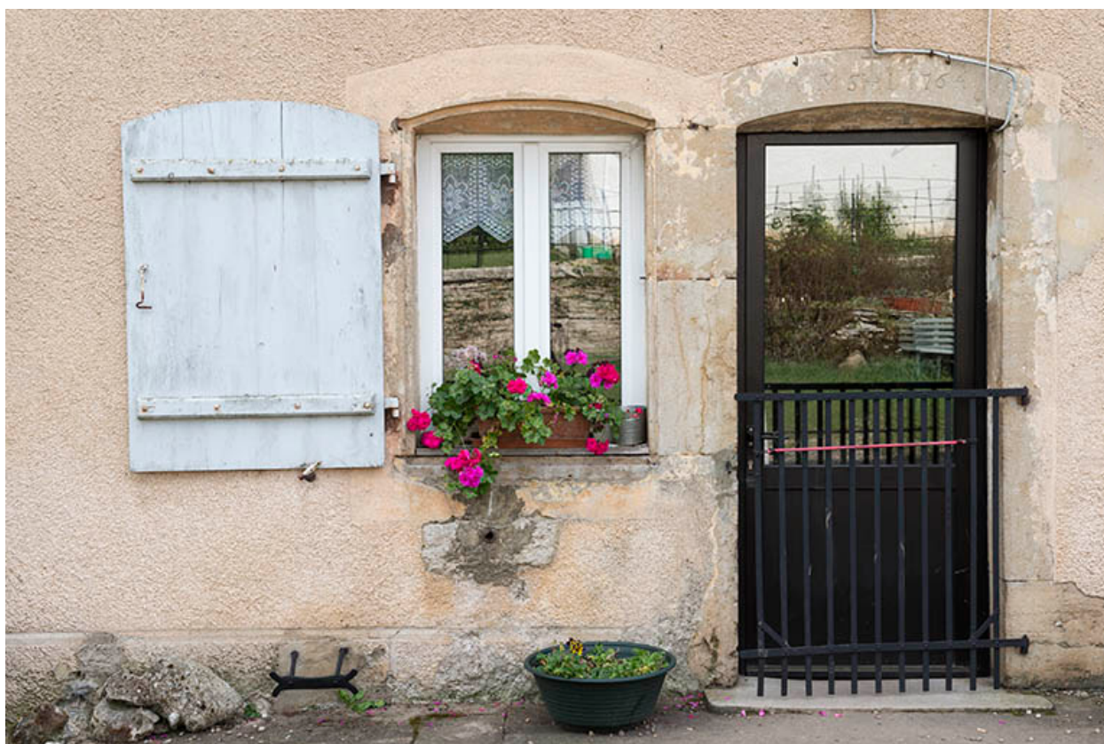
Détail, porte d'entrée de la partie habitation.
