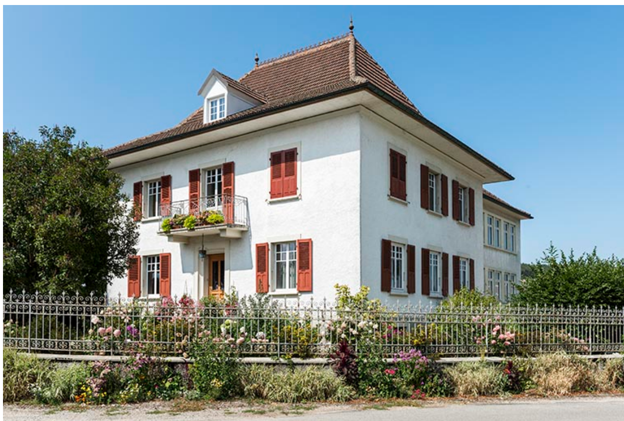
Maison : façades antérieure et latérale droite.
