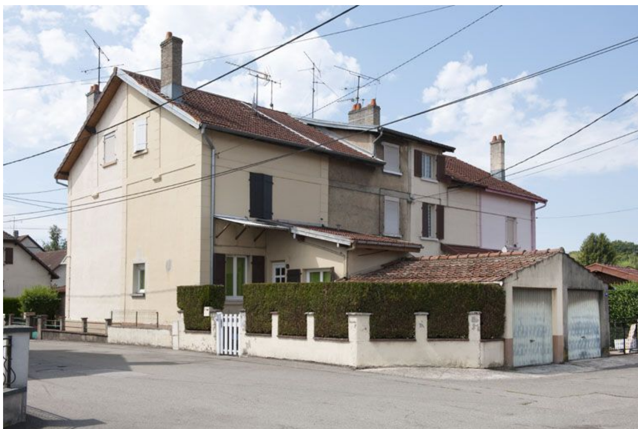
Habitation à 8 logements vue de trois quarts.
