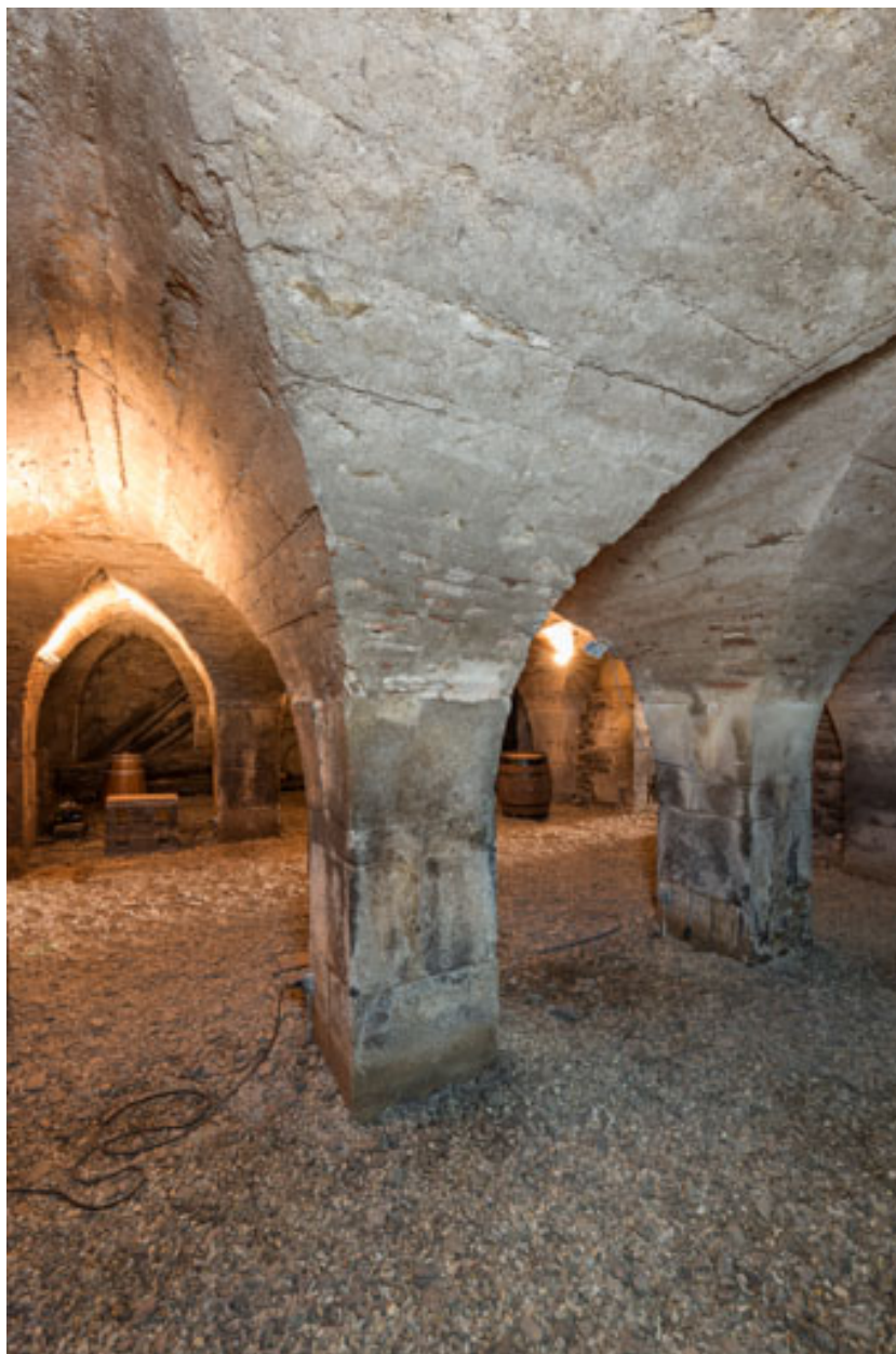
Pavillon occidental : cave à l'étage de soubassement.
