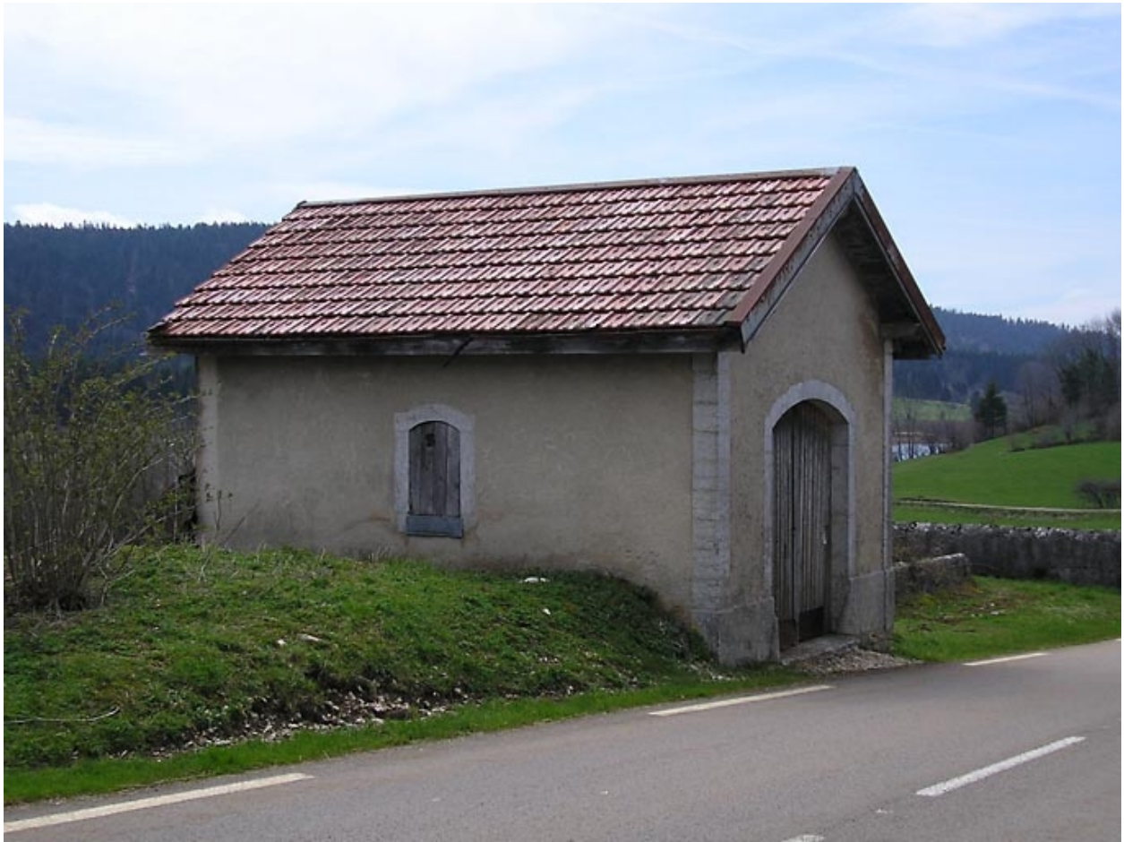
Remise de matériel incendie située au lieu-dit Le Crétet.
