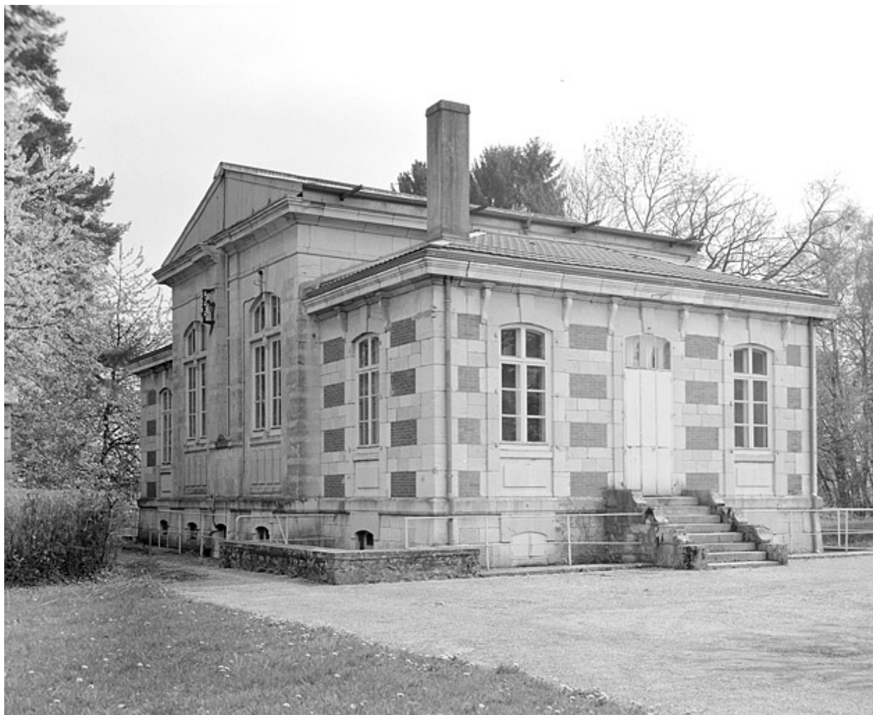
Façades nord et ouest.
