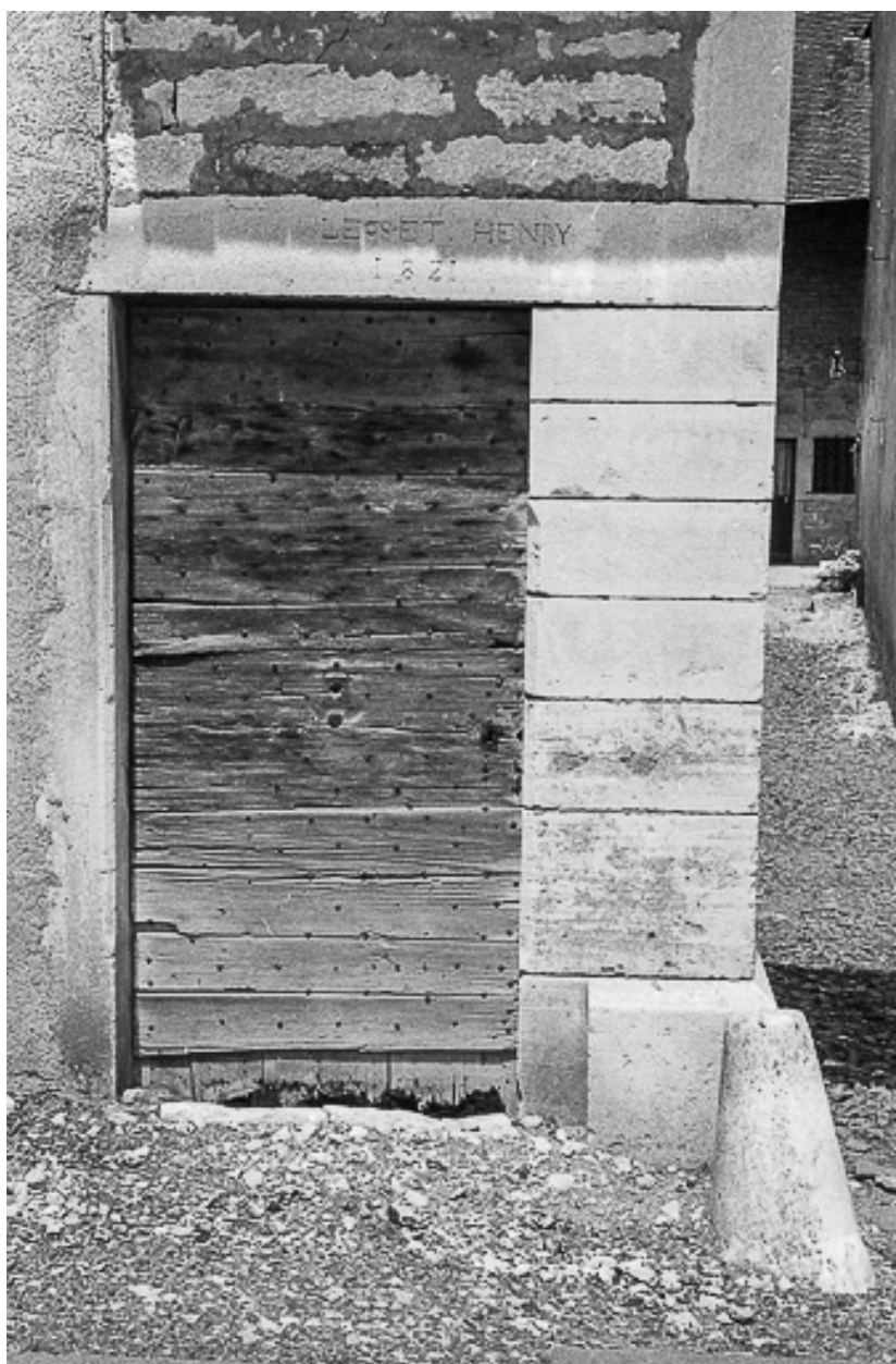
Détail : porte piétonne.
