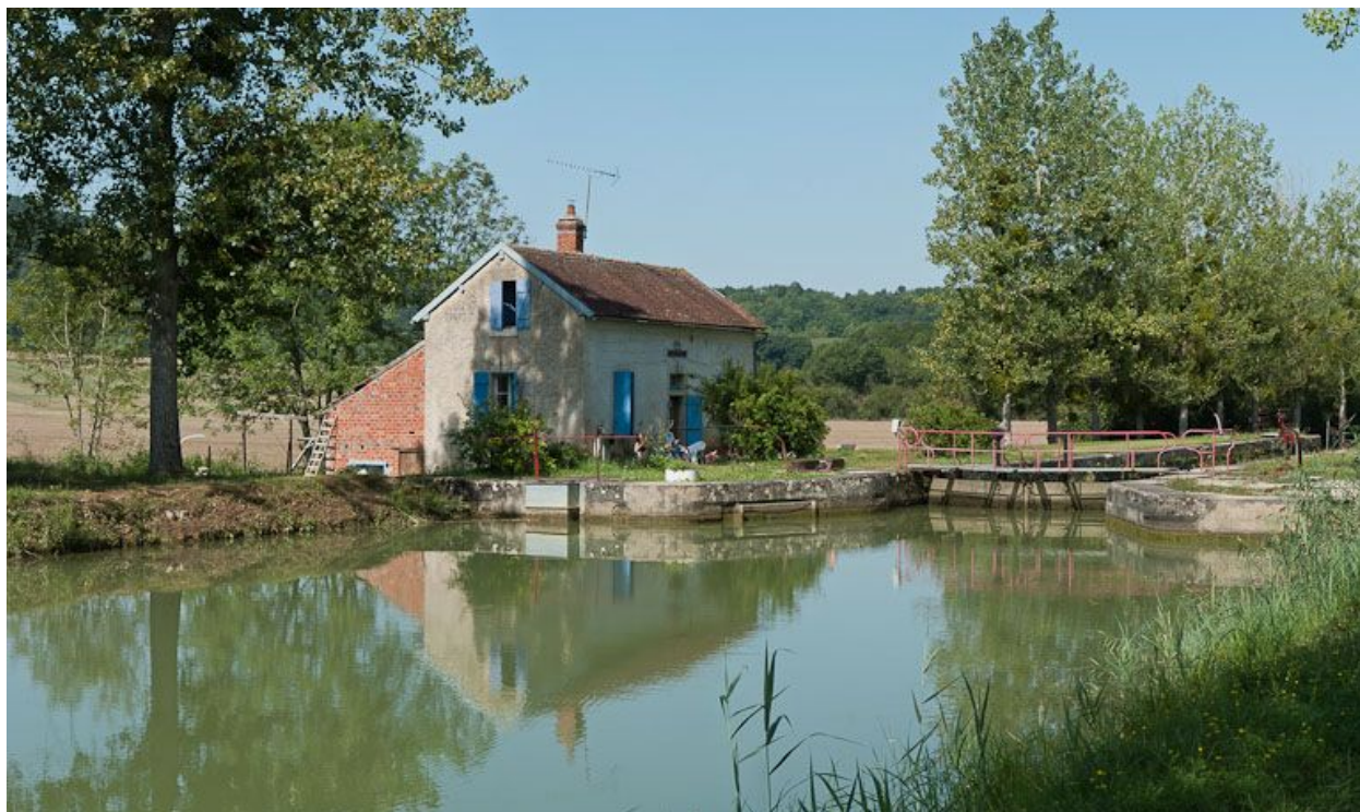
Vue du site d'écluse depuis l'amont.
