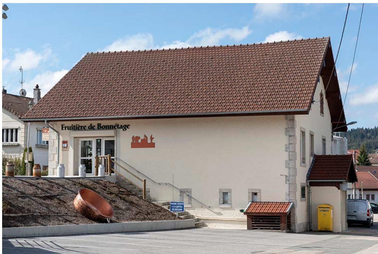
Façade latérale droite.
