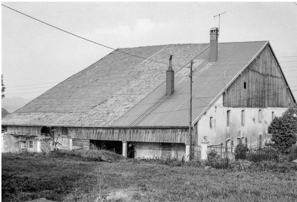
Façades antérieure et latérale gauche sur rue.
