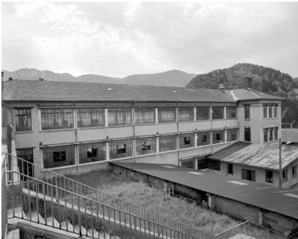
Façade latérale gauche du 1er bâtiment.
