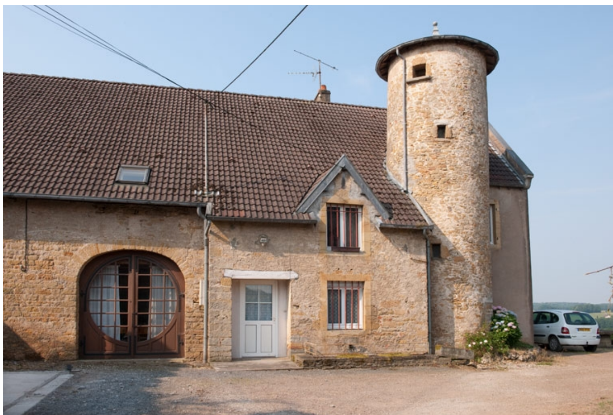
Façade antérieure, vue de trois quart gauche.
