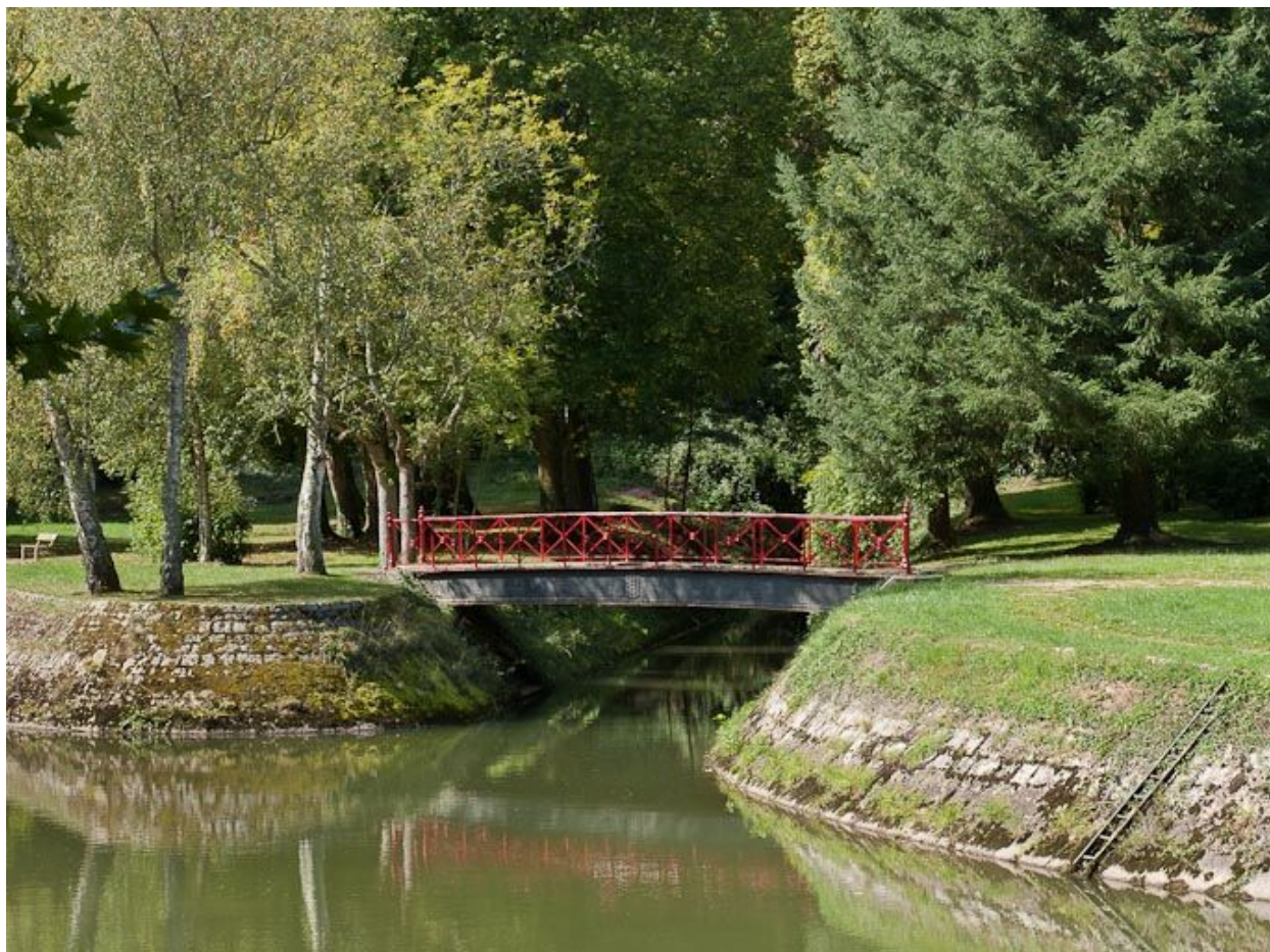
Vue d'un pont sur rigole.
