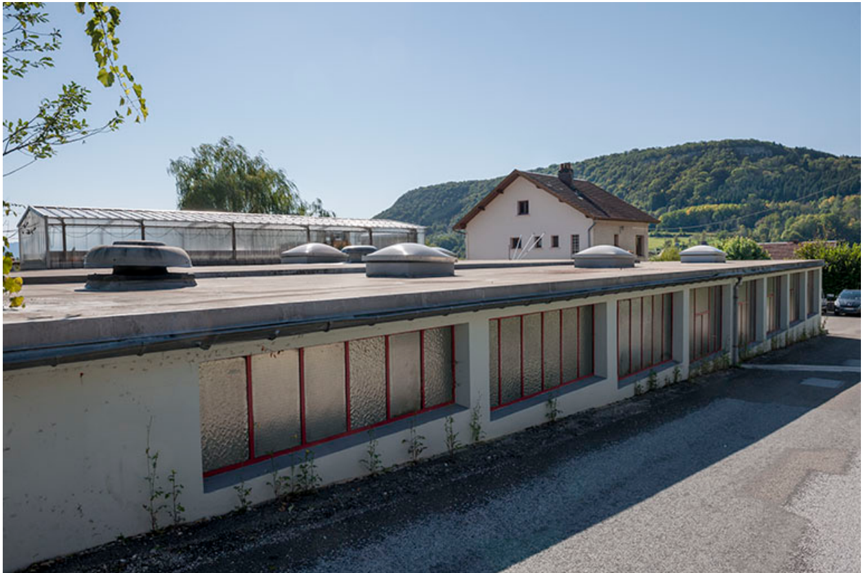
Façade sur rue de l'atelier de fabrication.
