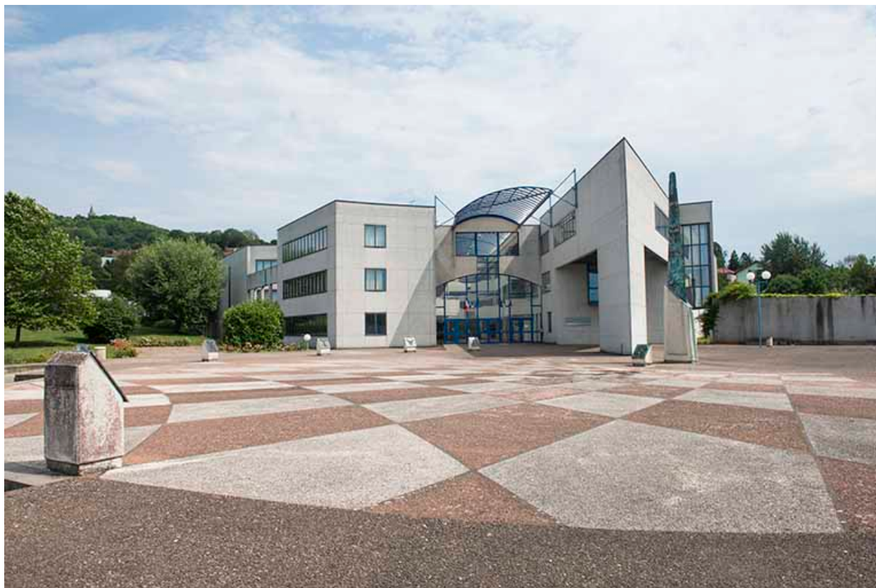
Entrée et façades nord.
