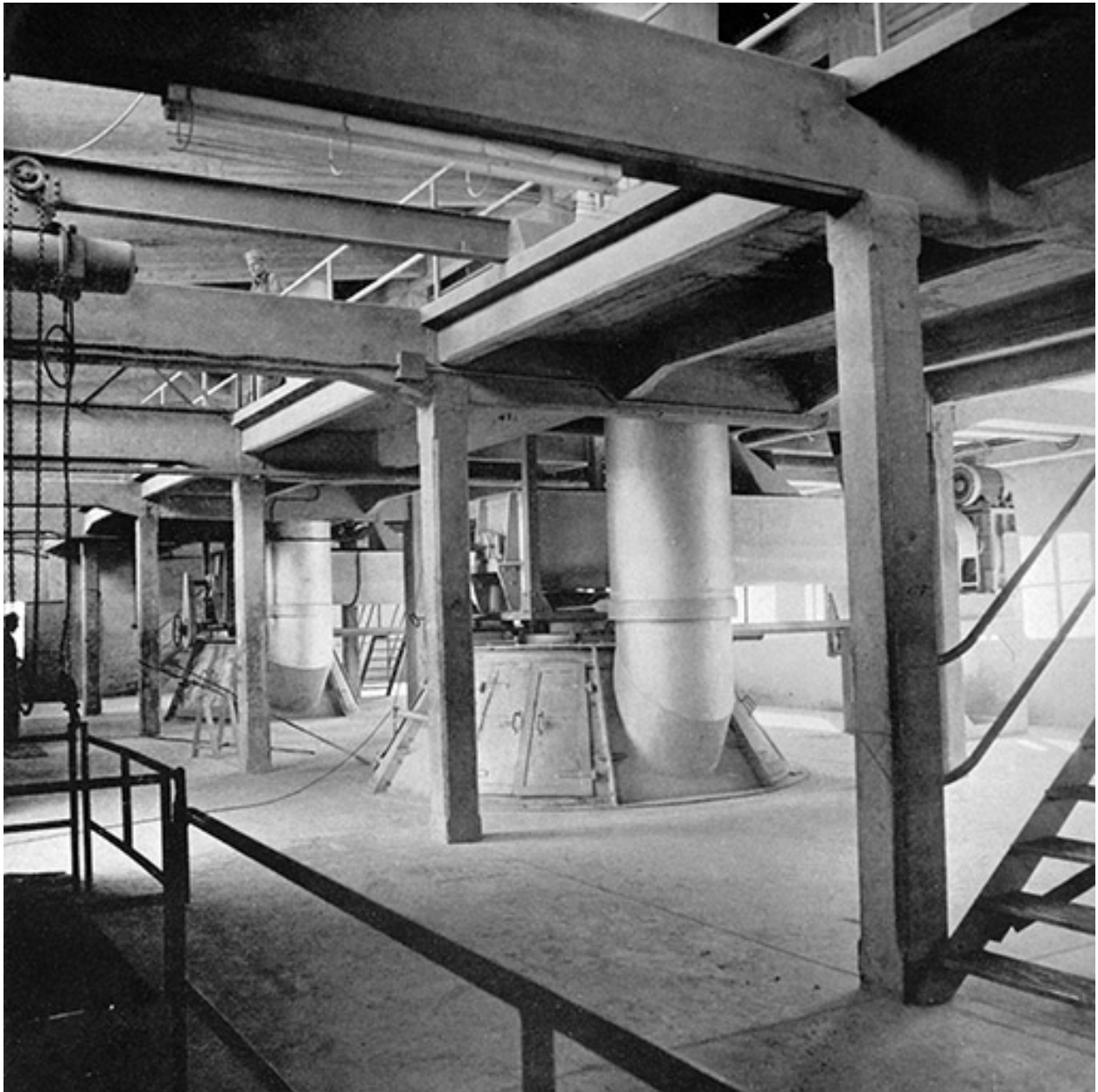
Etage supérieur des fours.
