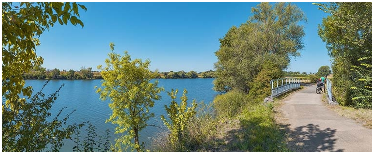
Le pont sur la Vandaine.
