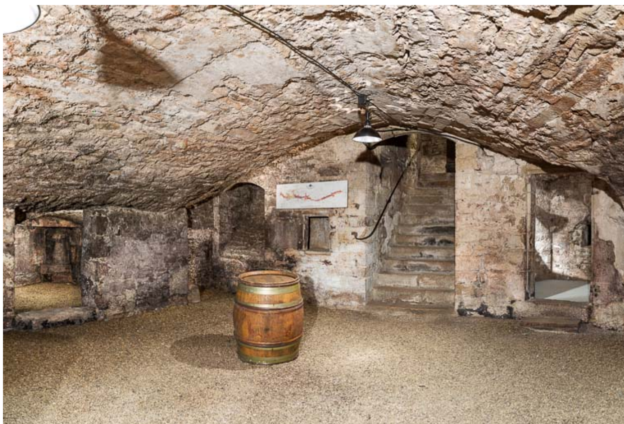
Casemate inférieure de la tour sud-ouest.
