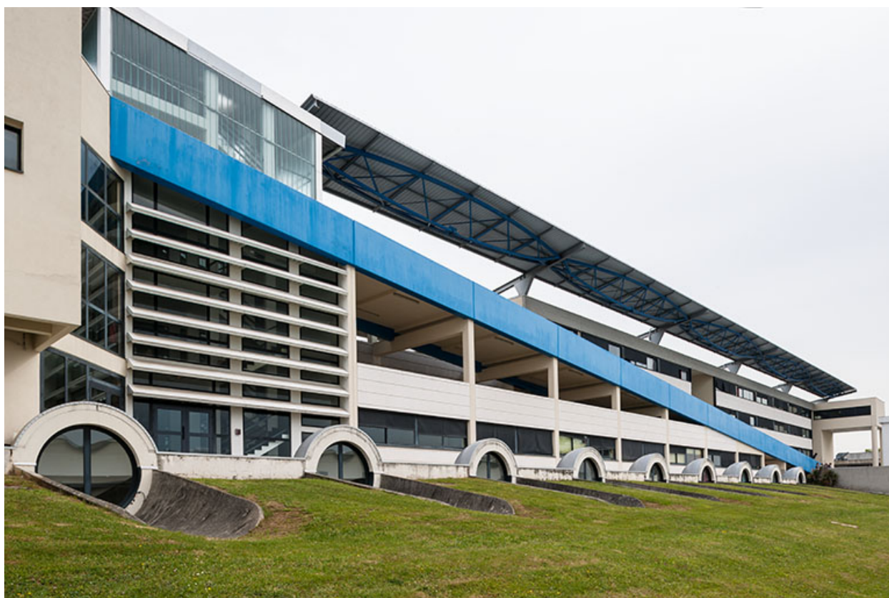
Bâtiment d'externat : façade antérieure.
