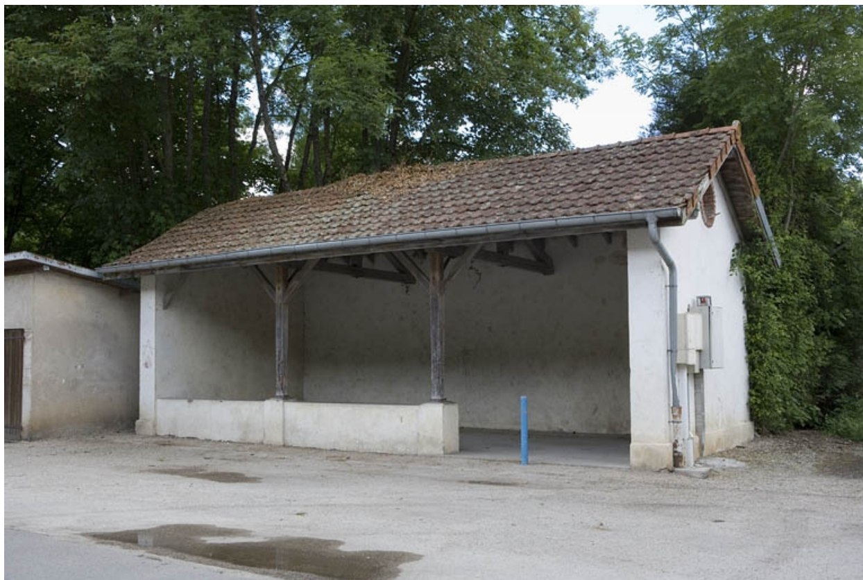
Cité ouvrière. Lavoir.
