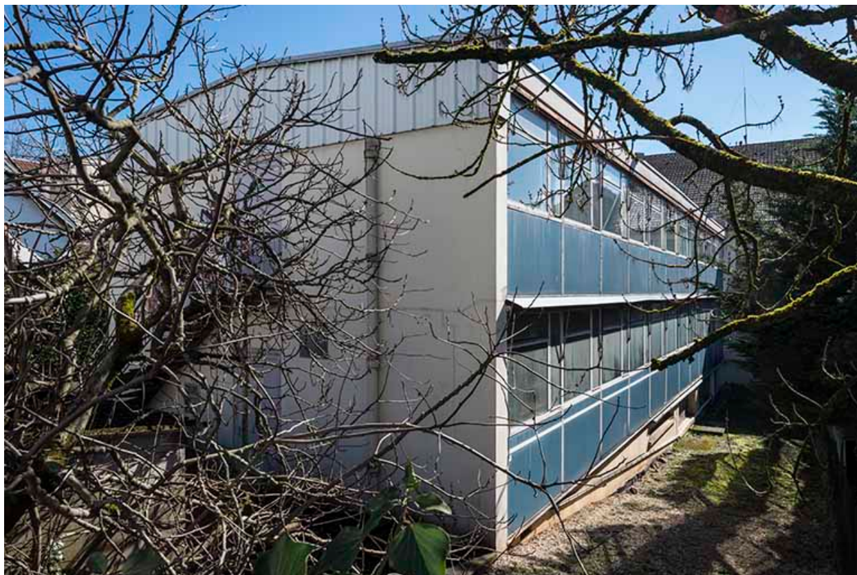
Extension nord, vue de trois quarts.
