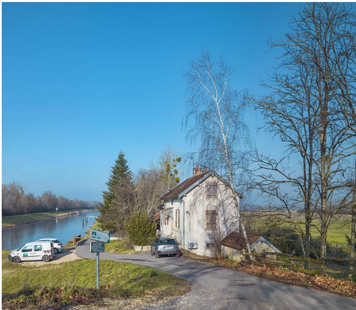
Pignon de la maison éclusière de Poncey.
