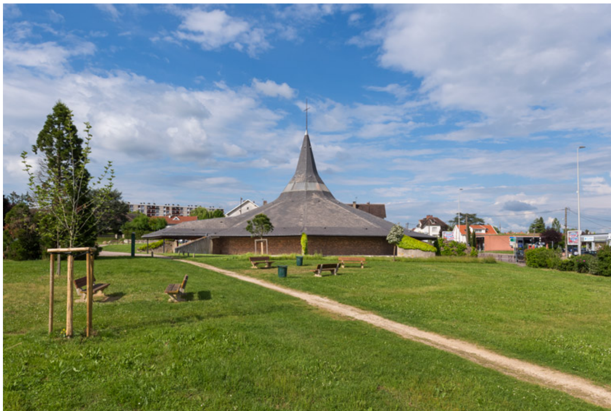
Vue depuis le sud.
