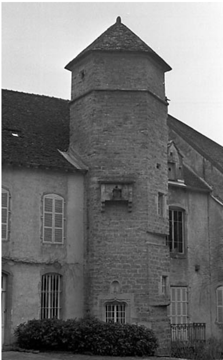
Détail de la façade antérieure.
