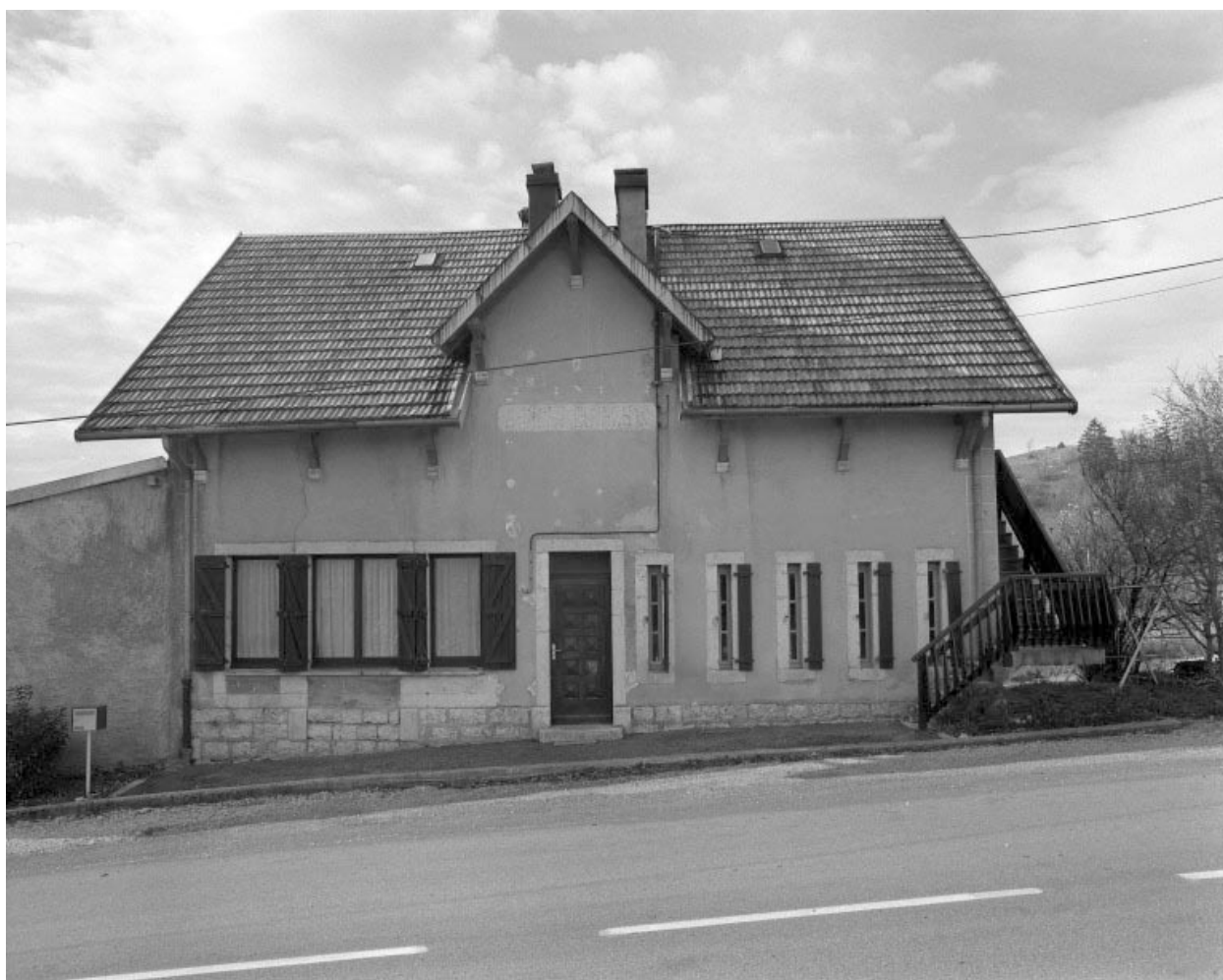
Façade antérieure du chalet du Rosay.
