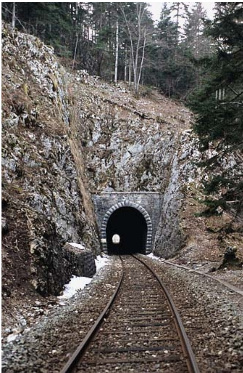
Tunnel : tête côté La Cluse.
