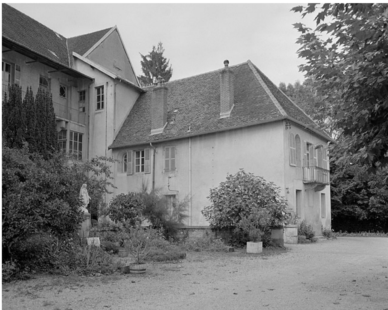
Façade latérale gauche du bâtiment A.
