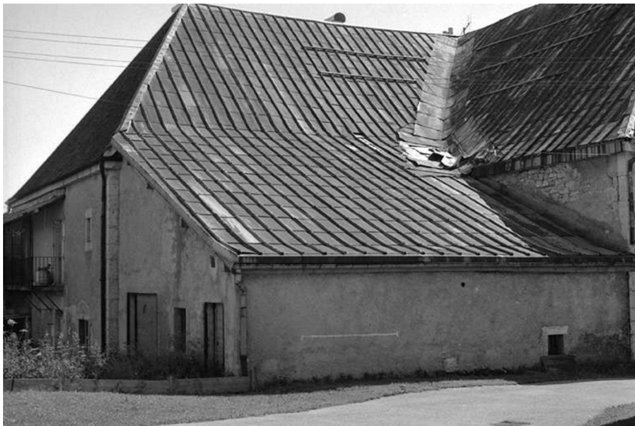
Façades postérieure et latérale droite.
