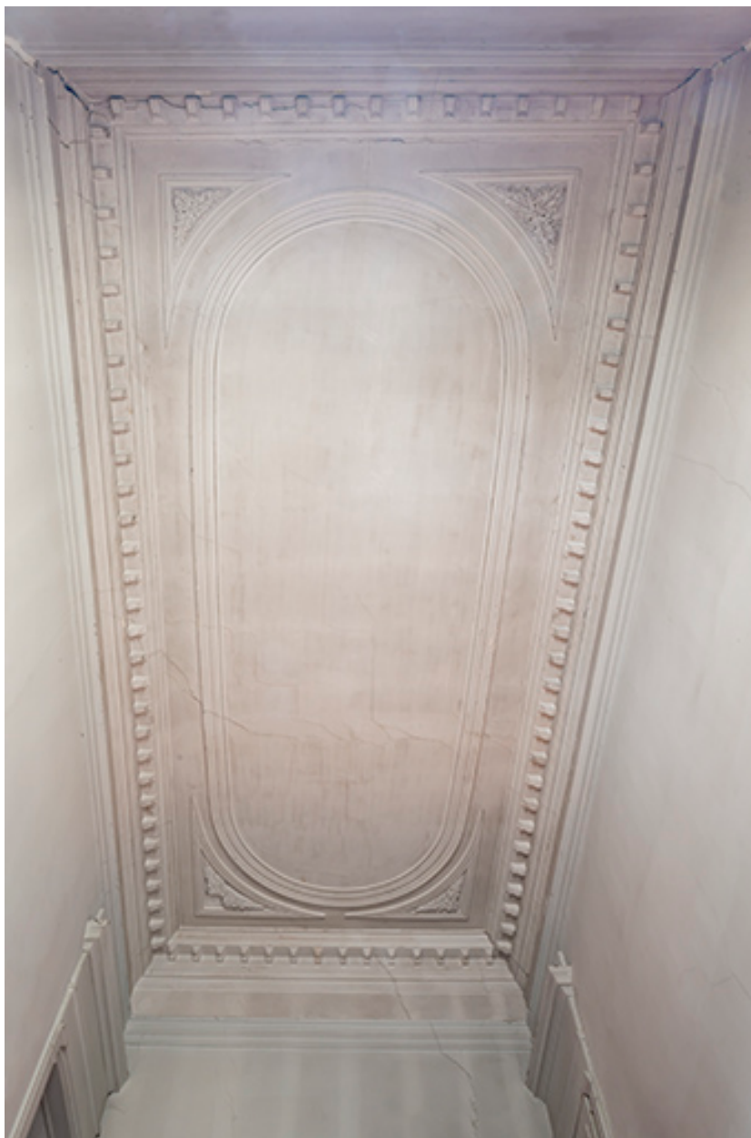
Plafond de la cage d'escalier.
