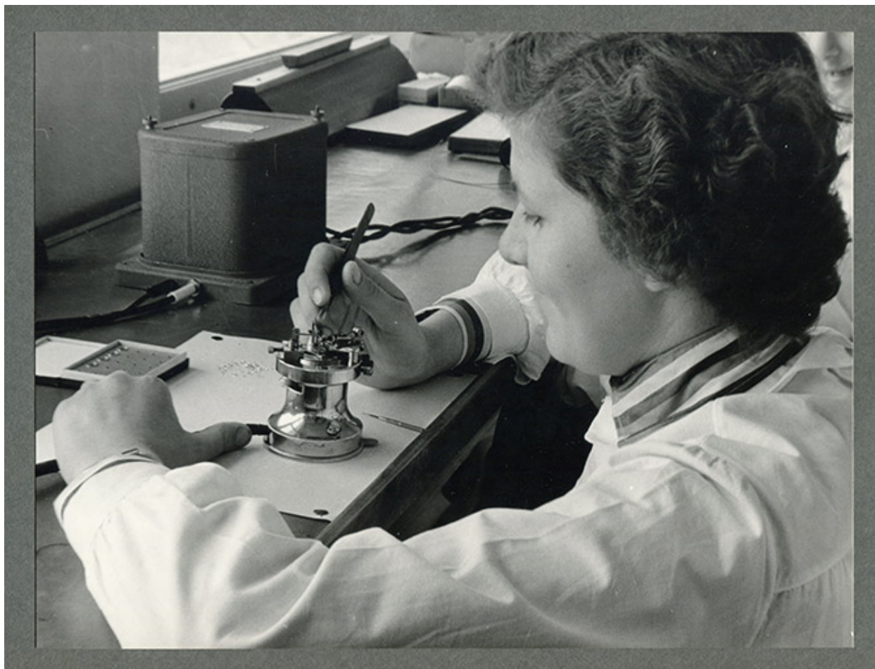
Ouvrière au travail : réglage du balancier-spiral, années 1960.
