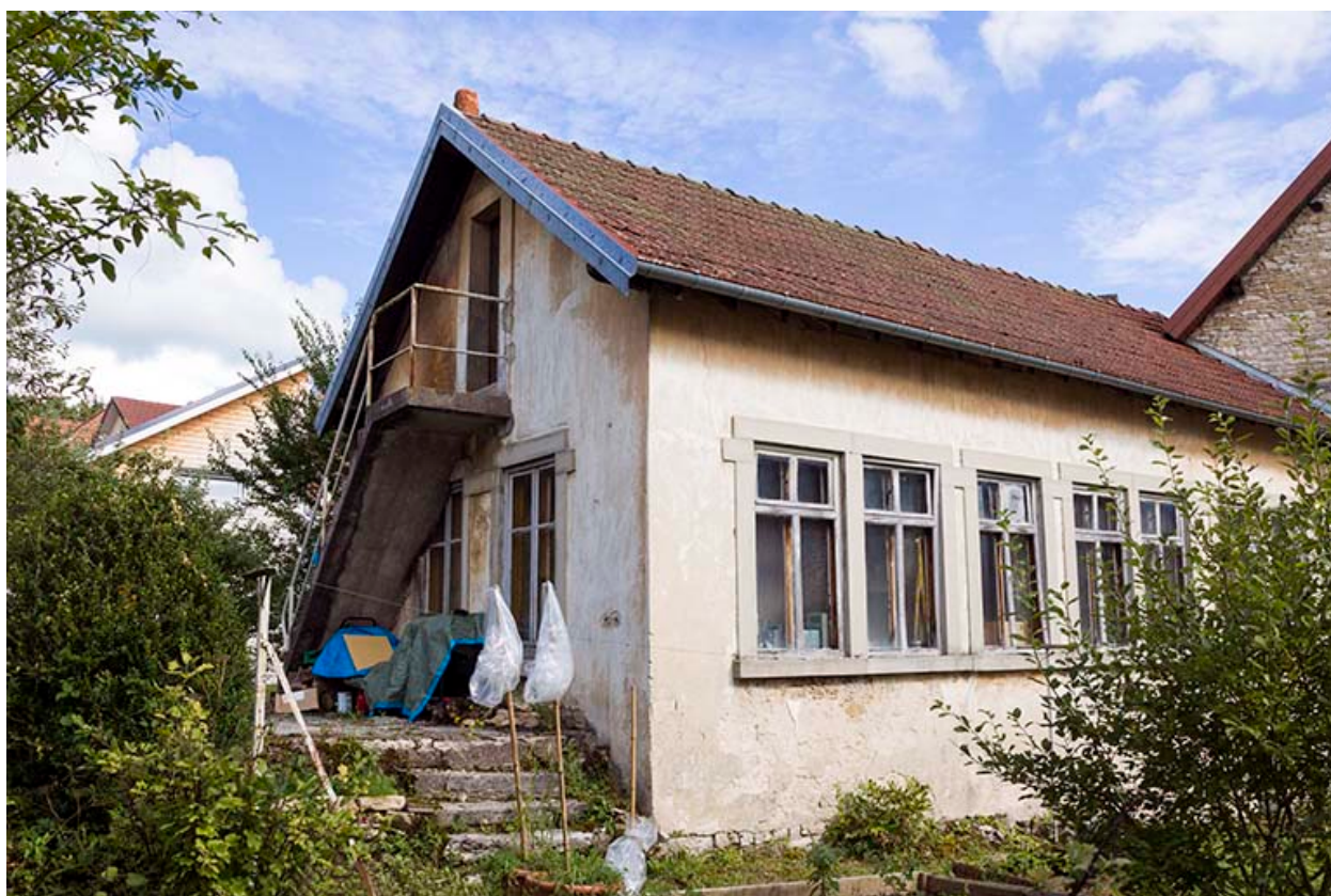
Usine : façades postérieure et latérale droite.
