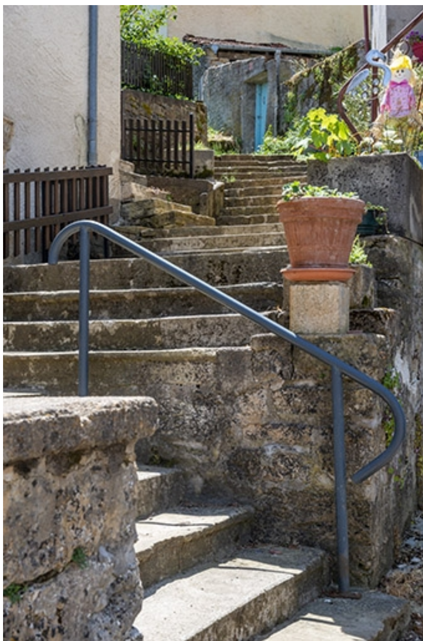
Escalier isolé au n° 51.
