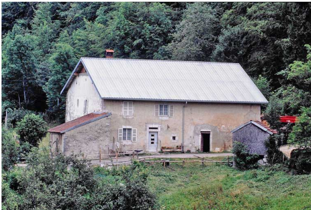
Vue éloignée de la façade antérieure.
