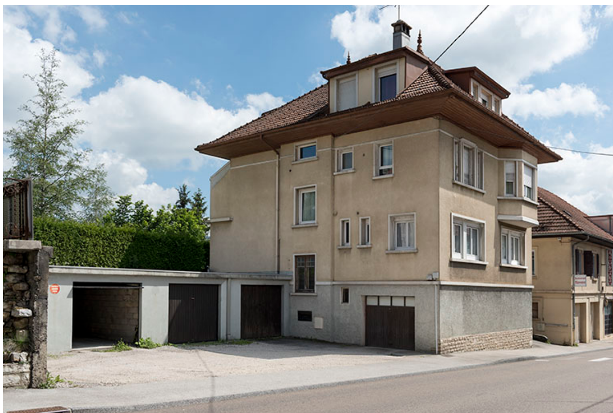
Façades antérieure et latérale gauche.
