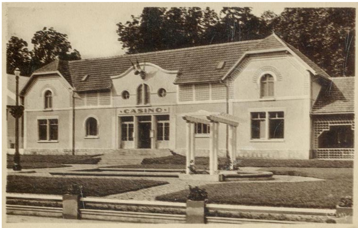
Façade sur la rue.
