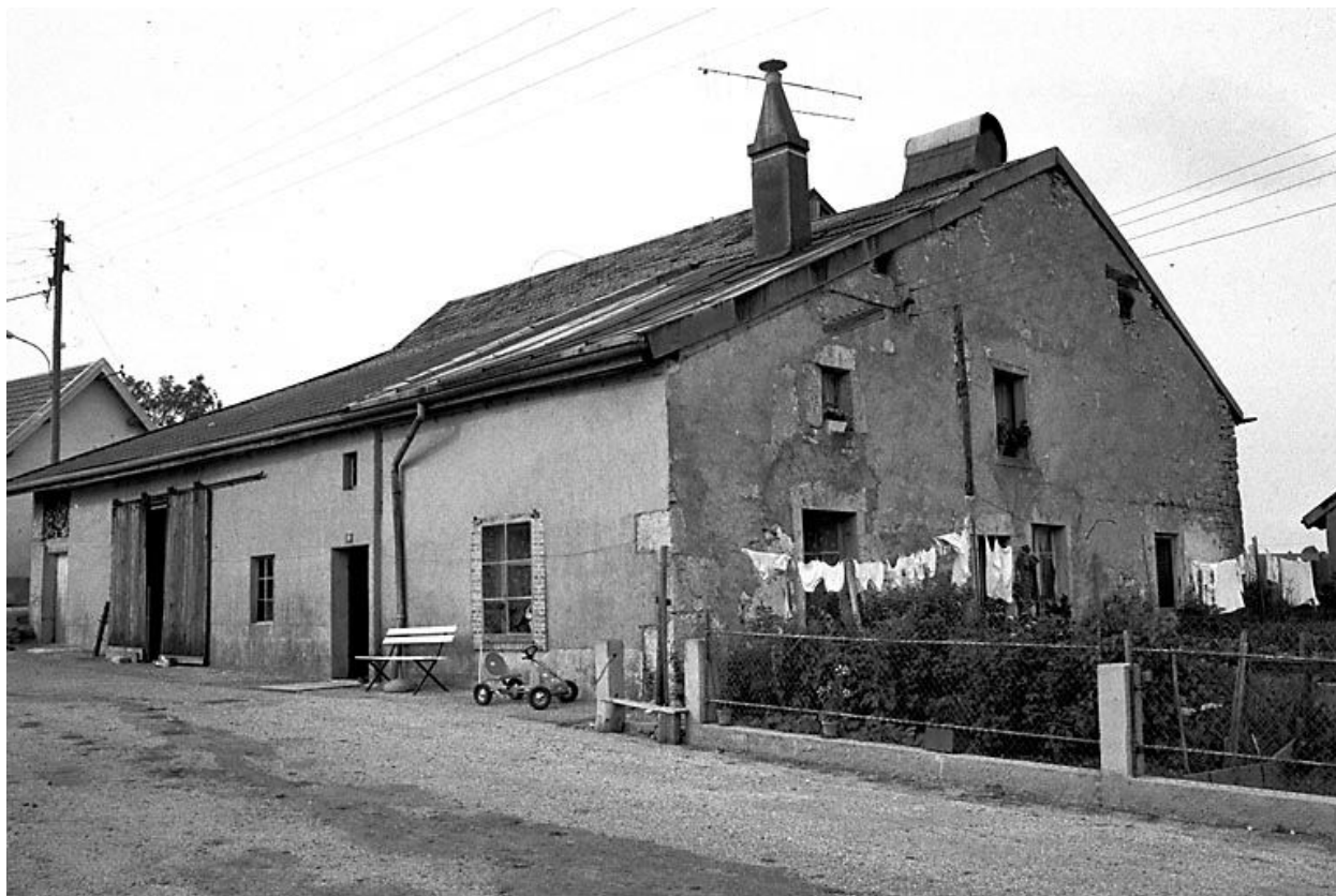
Ferme située rue Sainte-Anne : vue de trois quarts droit.
