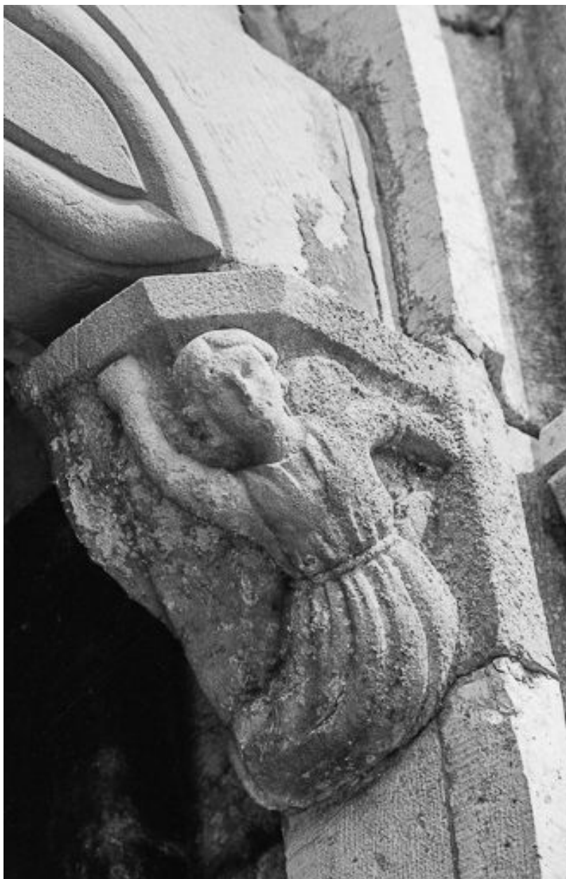
Extérieur : portail, façade antérieure, détail.
