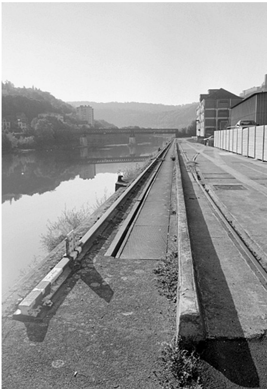
Port fluvial : quai et vestiges de la voie de roulement de la grue mobile, depuis l'aval.
