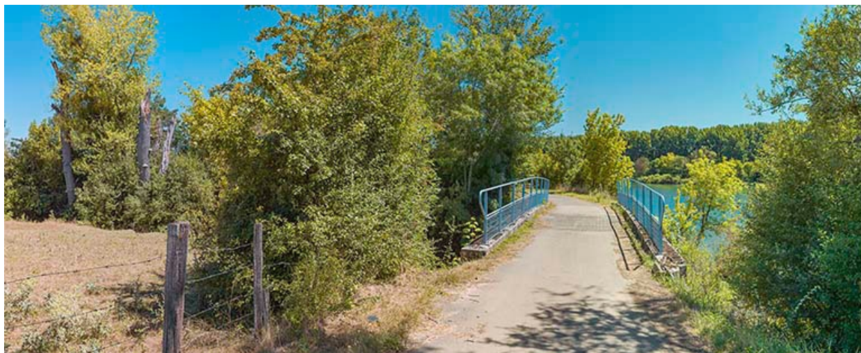
Vue du dessus et d'aval.
