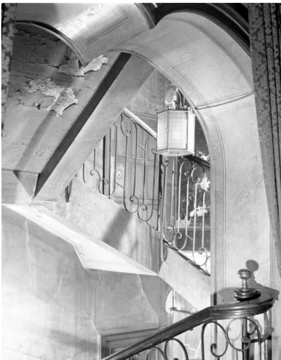
Logement patronal : cage d'escalier.
